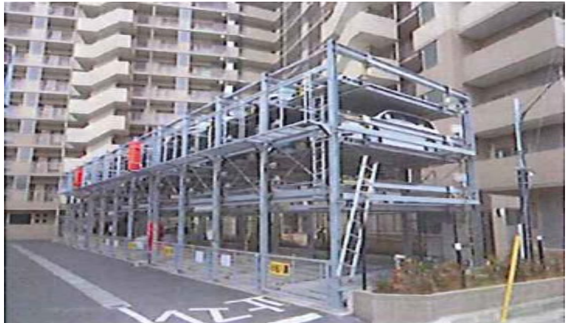
Lift and Shift System (Column Model) 横行昇降方式（縦列型）
